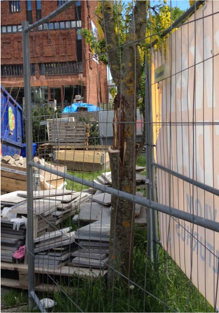
Figur 11. Inträngt och skadat träd bland byggmaterial och utan skydd. Med tydliga åtgärder för träd i handlingar, en genomtänkt upphandling och en trädcentral ska träd inte behöva hanteras på detta sätt under byggnationen. Foto: Maria Thorell, 2013.
